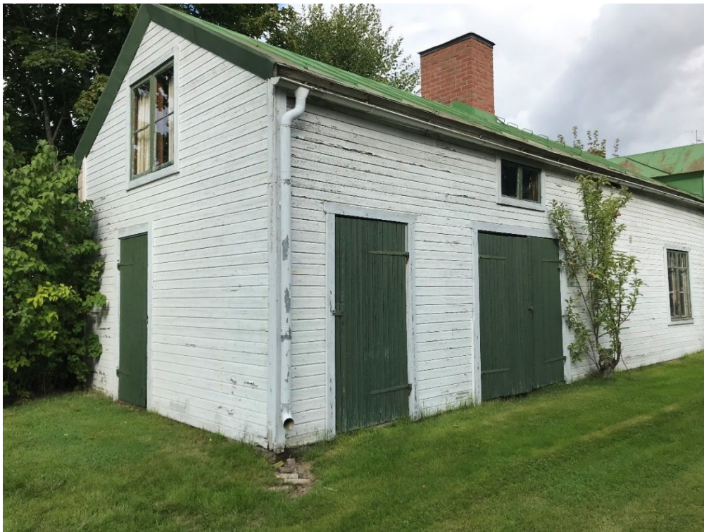
Bild 19: Bild tagen på komplementbyggnaden på Bagaren 10.
